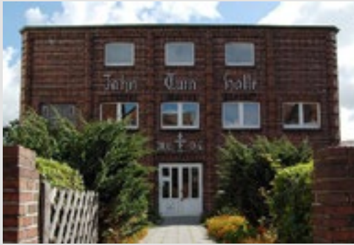
LSV-Geschäftsstelle und Jahn-Turnhalle in der Feldstraße 29
