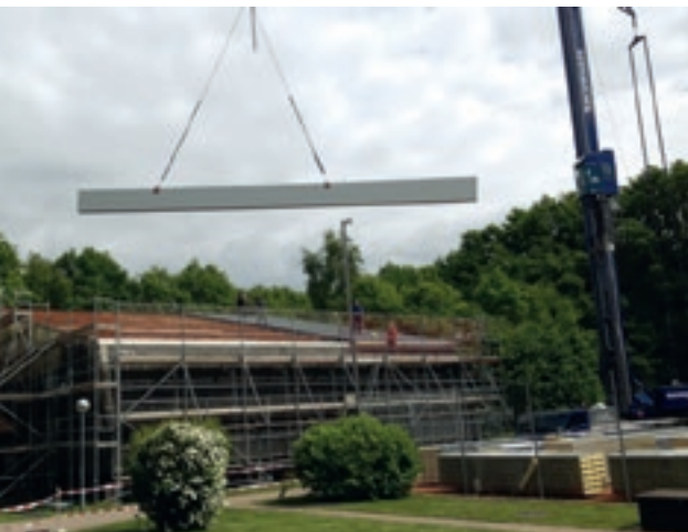
Ein riesiger Autokran legt die 25 m langen Sandwichplatten (120 mm gedämmt) auf das Dach
