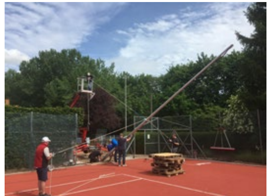
Bilder im Steiger bei der Aufstellung des vierten Mastes in Eigenleistung
