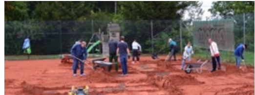
Mit vereinten Kräften, Abtrag der alten Ziegelmehldecke im Oktober 2019
