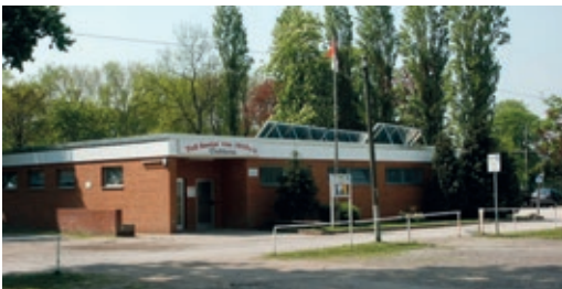
Eingang mit Solaranlage
